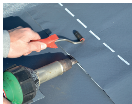
Collage de recouvrement avec un décapeur.
