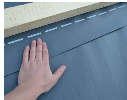
Exercer une forte pression sur la bande de toiture de recouvrement immédiatement après l'application de la colle.
