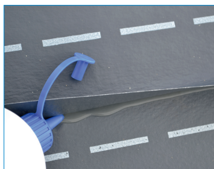
Collage de recouvrement avec l'OMEGA N55
