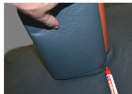
Reporter la pente de toiture sur le manchon préfabriqué et découper.
