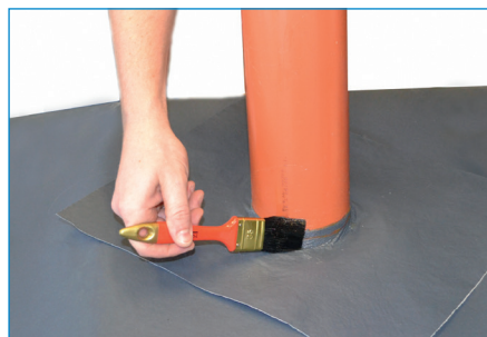
Recouvrir la partie inférieure d'OMEGA N55.
