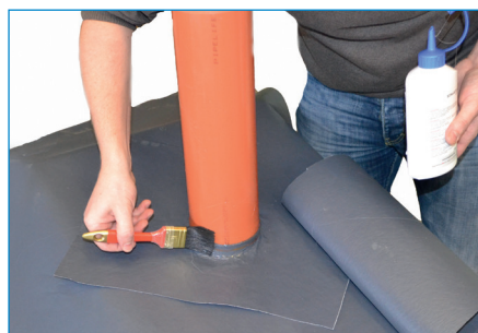
Recouvrir la partie inférieure d'OMEGA N55.
