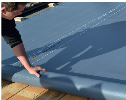
Pose et fixation sur un support fixe.
