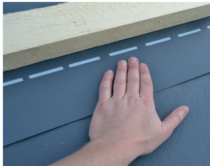
Exercer une forte pression sur la bande de toiture de recouvrement immédiatement après l'application de la colle.
