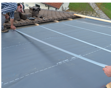
Les rubans d'étanchéité pour clous ISOCELL doivent être mis en place sous les contre-lattes.
